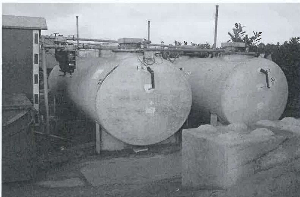
Foto 2 Onderzoeksgebied op de locatie Beusingsedijk 8 te Den Dungen, bovengrondse tanks.
