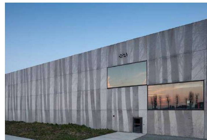
Bedrijfsgebouw voorzien van betonpanelen met een structuur.
