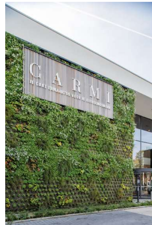
Bedrijfsgebouw voorzien van groene gevel
