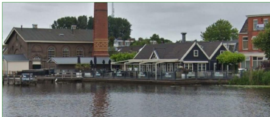
Figuur 1. Aanzicht van de planlocatie waarop de damwand en steiger zichtbaar zijn.
