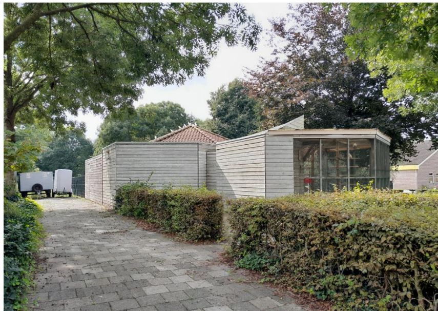
Figuur 6: Het hoofdgebouw van het dierenparkje gezien vanuit noordwesten
