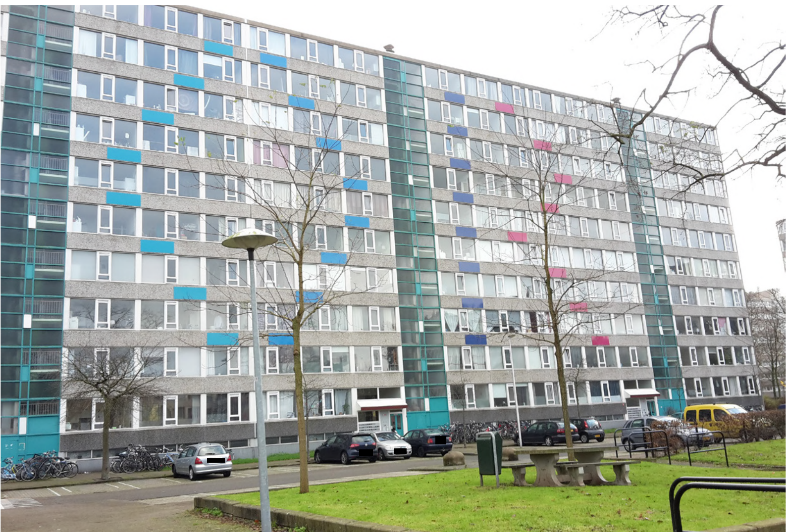
De noordwestzijde van het te slopen pand
