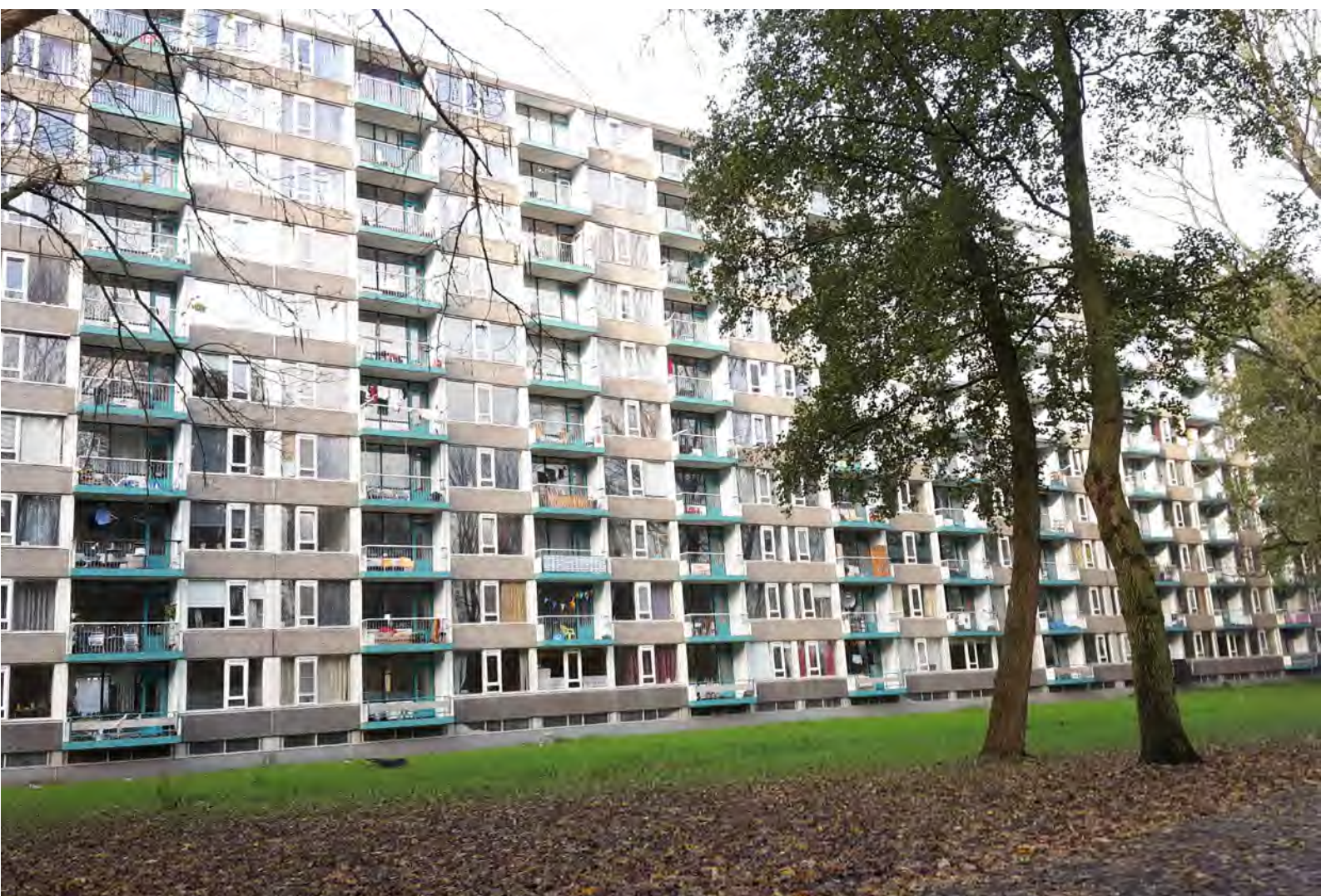
De zuidzijde van het te slopen pand
