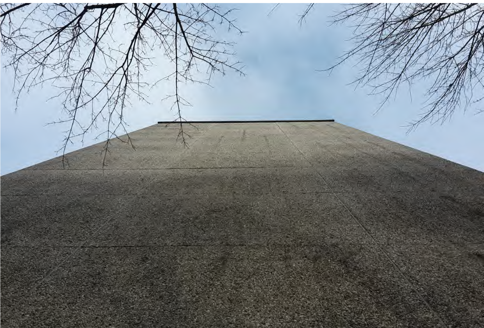
Een kopgevel van het te slopen pand
