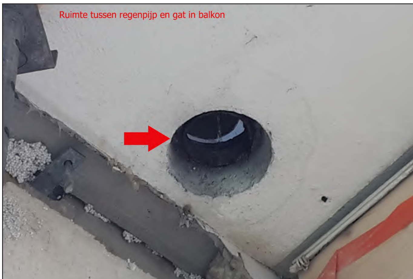
Gaten in de balkons. Hier loopt normaal de regenpijp door, maar tussen het balkon (alleen aan zuidoostkant) en de regenpijp is dan wel ruimte voor kleine verblijven zoals paar- en zomerverblijven. Vermoedelijk bevinden de zomerverblijven zich hier
