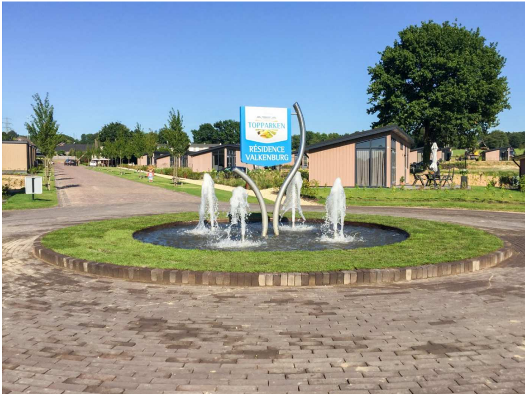
Figuur 11: Reeds aangelegde nieuwe hoofdweg
