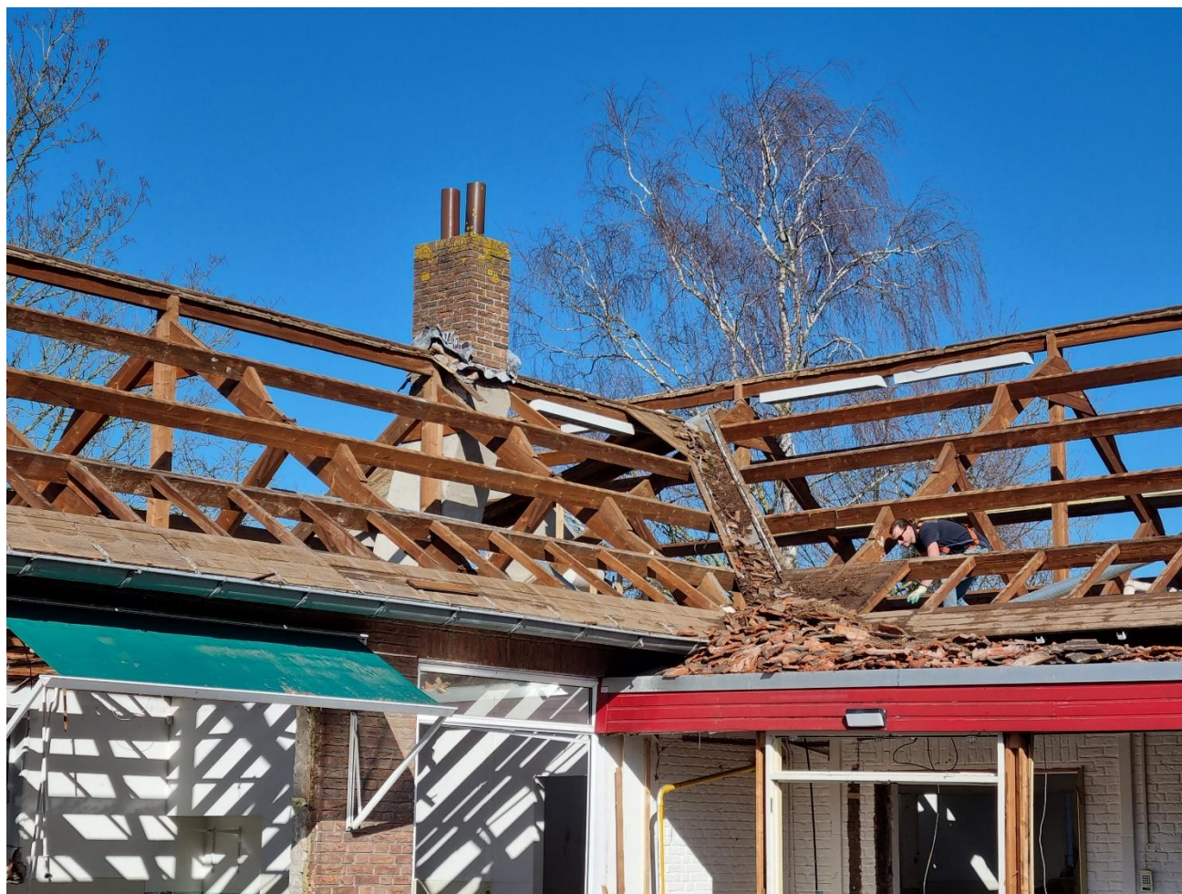
Figuur 6 Dak bijgebouw compleet geopend
