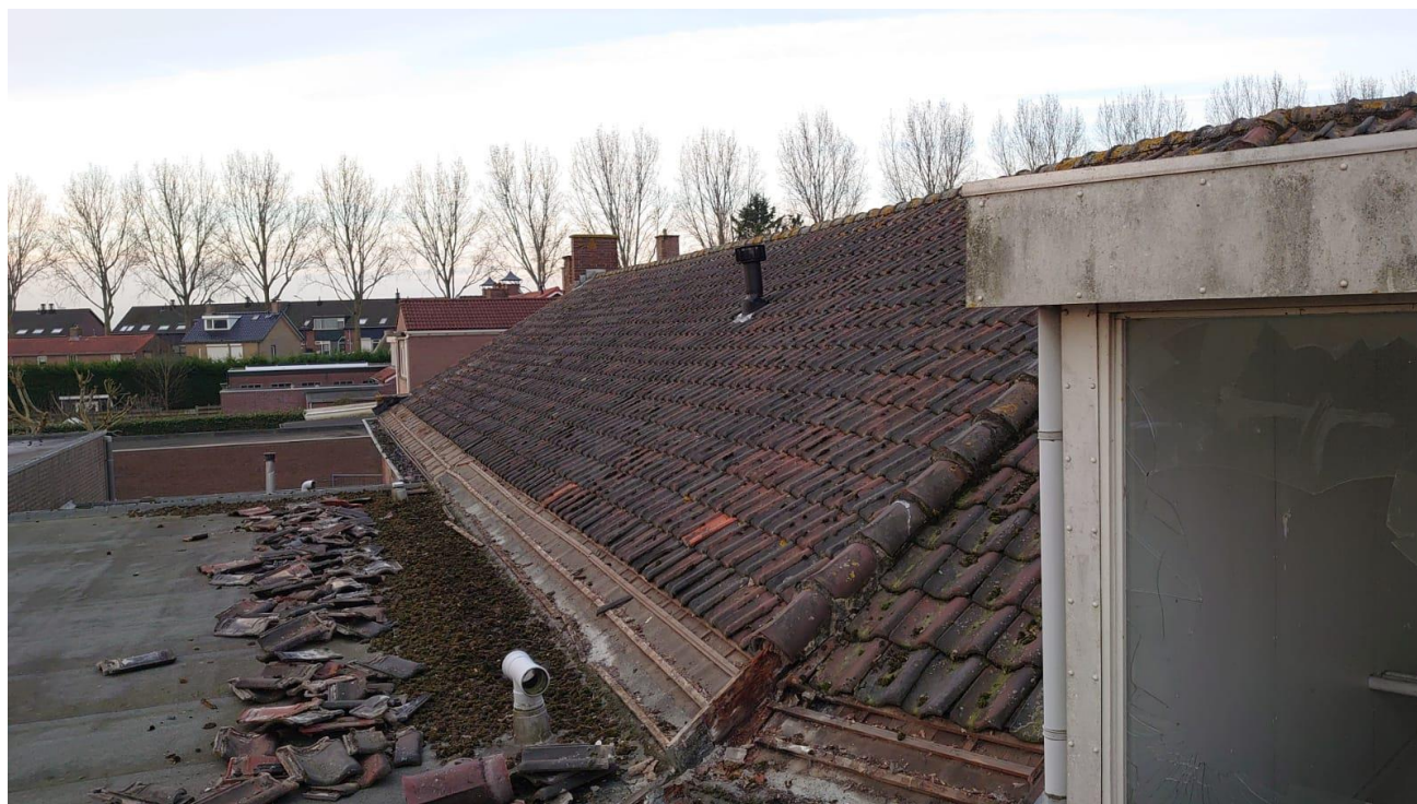
Figuur 9 Onderste rijen van dakpannen verwijderd van het resterende dak van het hoofdgebouw
