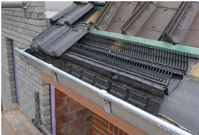
Figuur 3 Mussenvides onder eerste rij met dakpannen (Monier)
