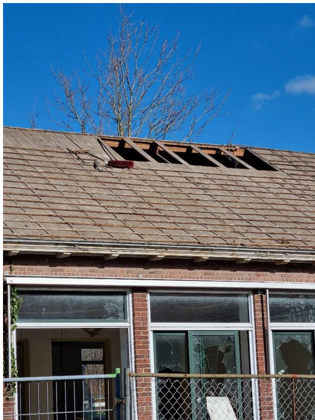
Figuur 7 Pannen verwijderd van het eerste deel van het dak van het hoofdgebouw
