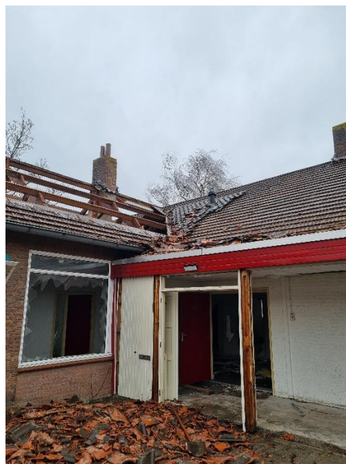
Figuur 5 Reeds geopende aansluiting van daken
