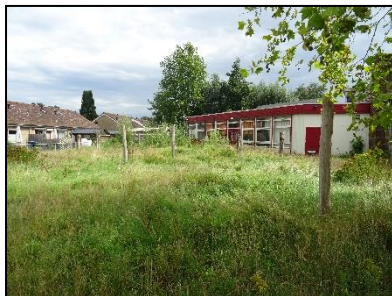
Figuur 6. Achteraanzicht van de bebouwing.
