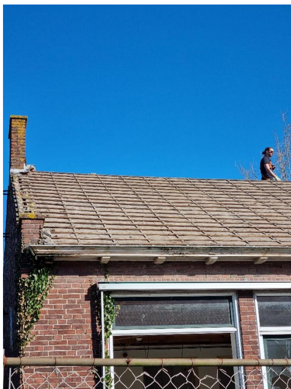
Figuur 7 Pannen verwijderd van het eerste deel van het dak van het hoofdgebouw
