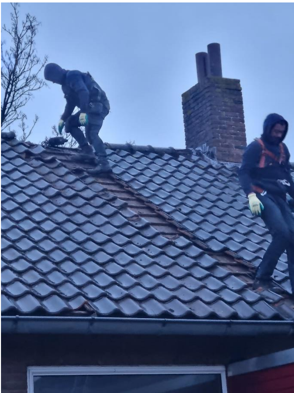
Figuur 3 Looppad bij start en aanbrengen valbeveiliging en ingestort dak door houtrot/houtworm
