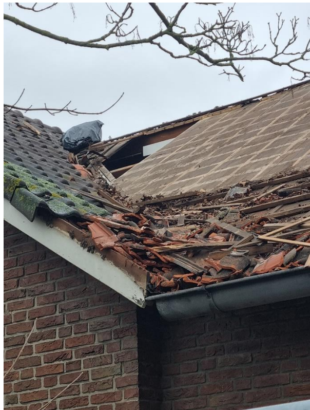
Figuur 3 Looppad bij start en aanbrengen valbeveiliging en ingestort dak door houtrot/houtworm
