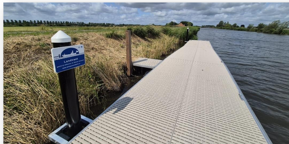
Figuur 2: Een nieuw gerealiseerde landvastlocatie inclusief bebording
