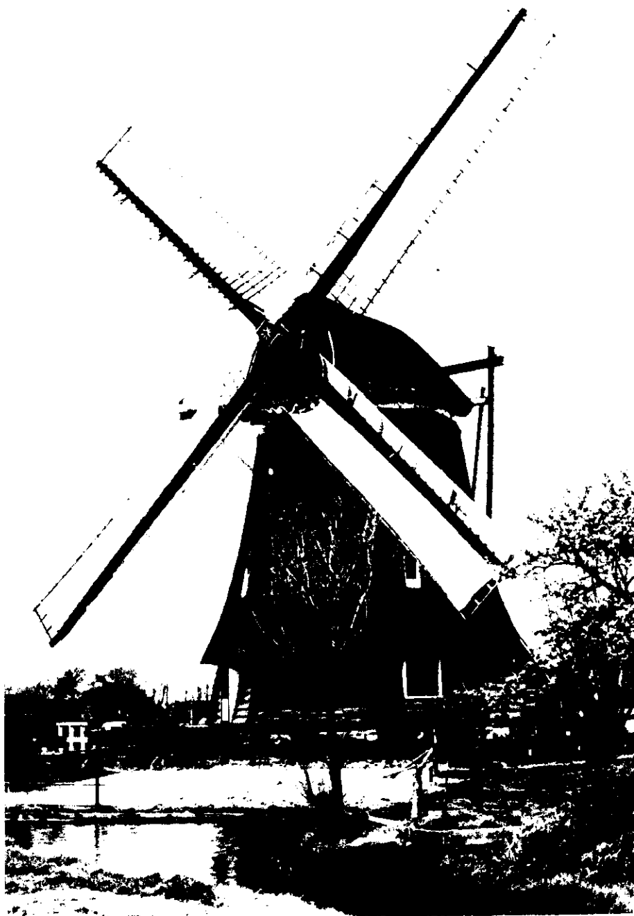
Afb. 13-11. Poldermolen 'De Dog' te Uitgeest, bemaalt de Castricumerpolder (645 ha.), voorzien van fokken op beide roeden. Gebouwd: 1896. Roedlengte: 25,80 m.
