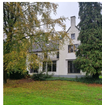
3. JKF kindervonds | Dit gebouw, gebouwd in 1950, zal worden behouden in de te ontwikkelen plannen
