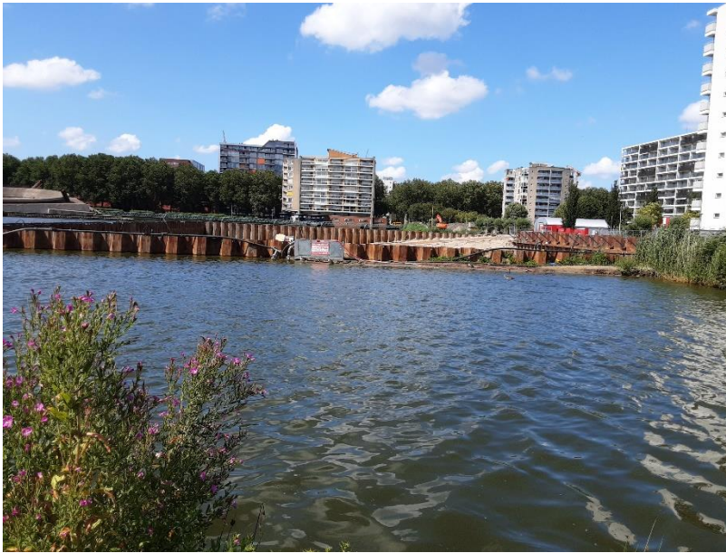
Bouwput Berninitoren 72 appt.
