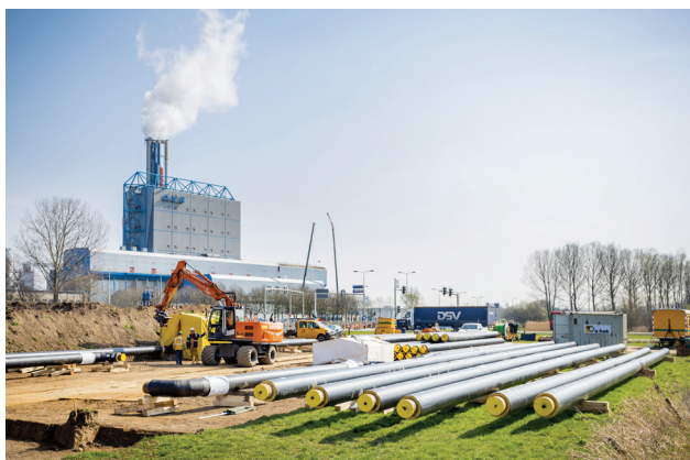
Aantakking warmtenet op AVR Duiven
