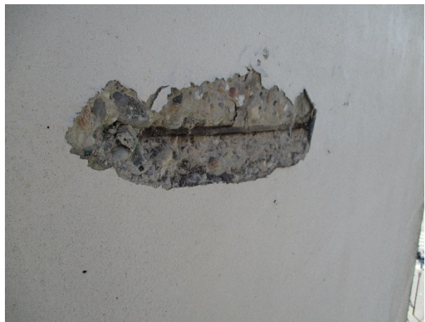
Figuur 8.12: Afgedrukt en losliggend beton met wapeningscorrosie, binnenzijde wand C.
