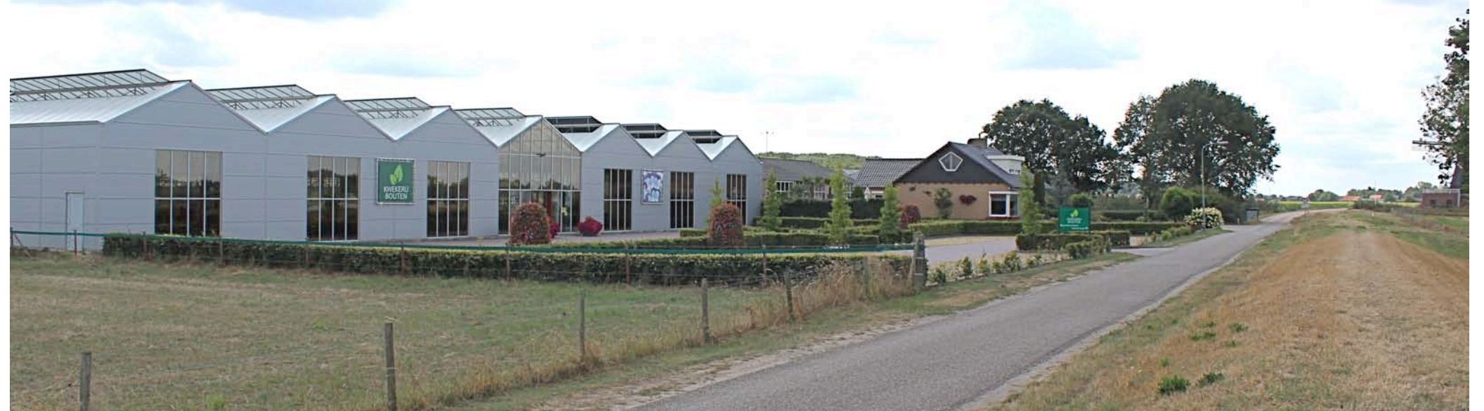
2) vanaf de weg Ouddorp, ter hoogte van het plangebied; beplanting op het voorterrein, dijk en doorkijk
