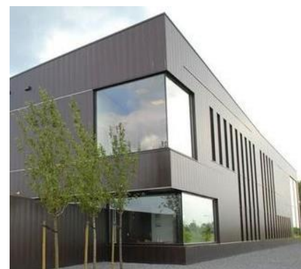
Hoekoplossing met glas en plaatmateriaal
