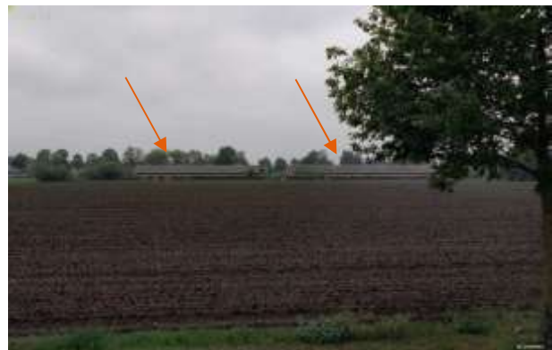
Foto 11: schuren met asbestverdacht dak op achterterrein van Burgt 10a (vanaf de Bovenstehuis)
