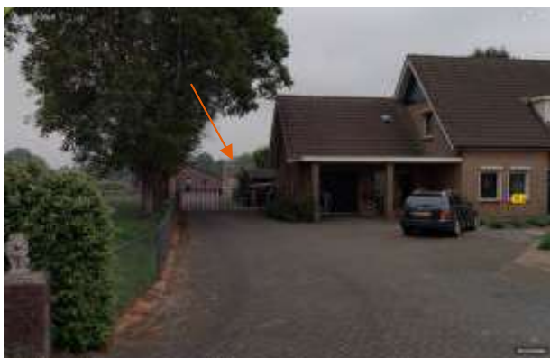
Foto 8: schuren met asbestverdacht dak op achterterrein van Burgt 10a
