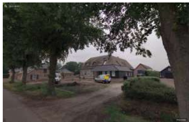
Foto 9: recente bouwactiviteiten op het perceel van Burgt 15b
