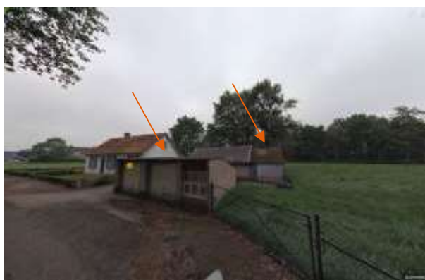
Foto 20: schuurtjes met asbestverdacht dak op perceel van Bernhardstraat 23
