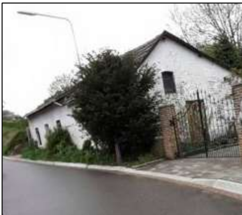
Foto bestaande situatie
