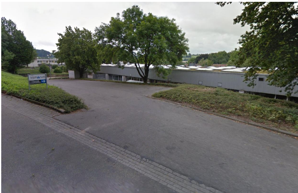
Figuur 3. Bebouwing gezien vanaf de ingang aan de Hofstraat (bron: Google Maps)
