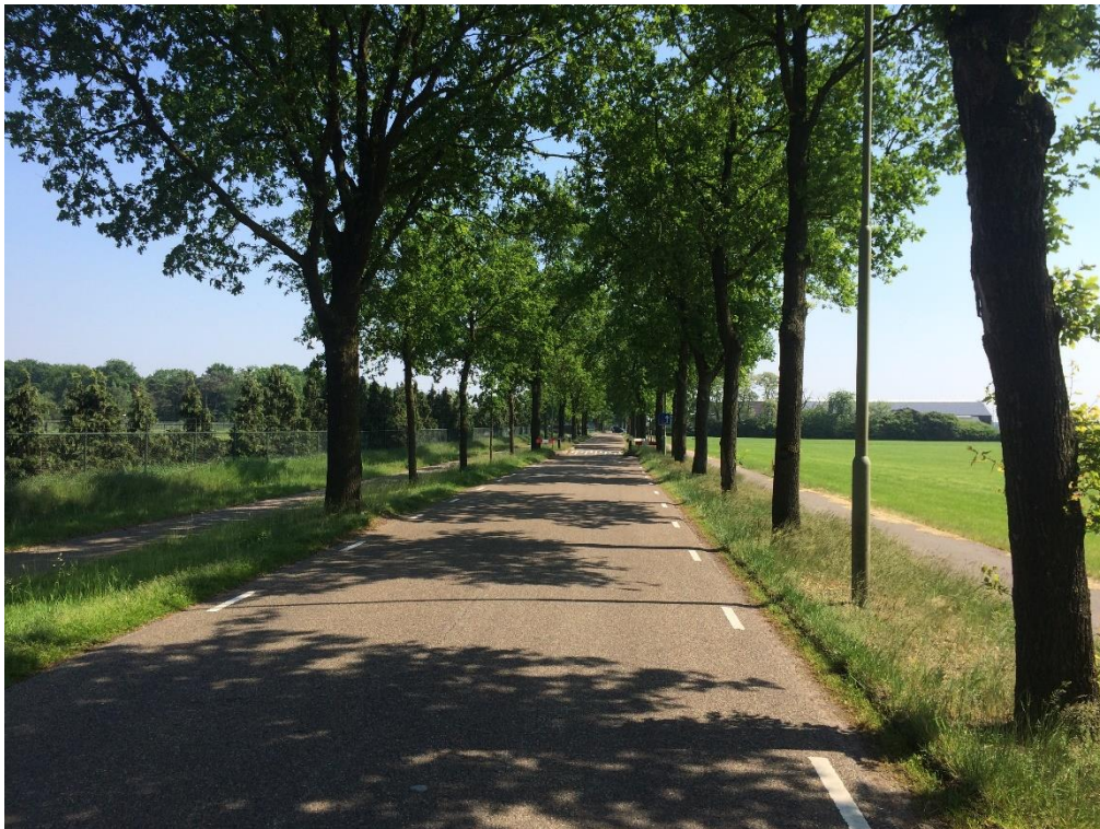
Wegprofiel Zeelandsedreef (richting het zuiden)
