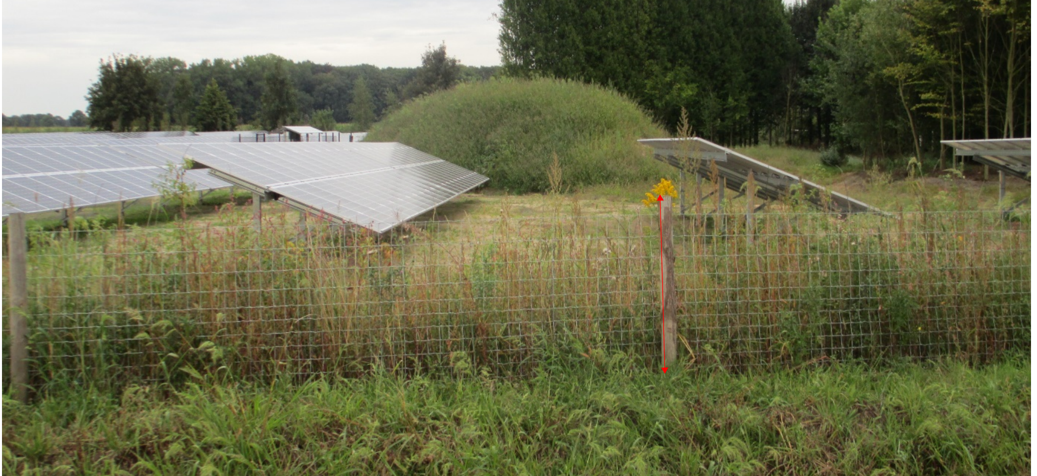
Hoogte hekwerk 1,8 meter
