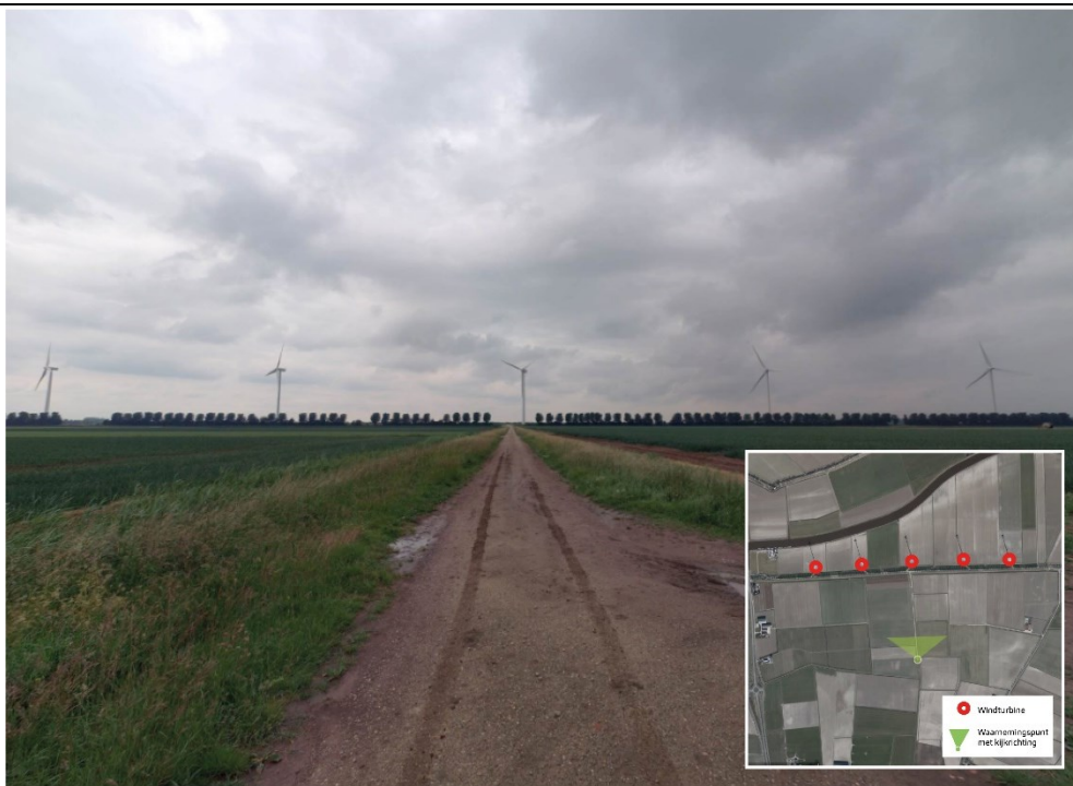
Figuur 30 Voorbeeld van rechte herkenbare lijnopstelling. (Windpark St. Antoinedijk, gemeente Halderberge). De opstelling is vanuit alle kanten herkenbaar als een strakke rechte lijn in het landschap.
