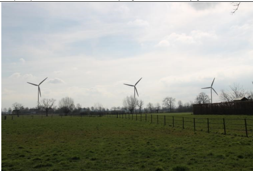
Figuur 23 Windpark op een afstand van ca. 10 keer de tiphoogte: de windturbines zijn goed zichtbaar.
