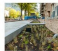
Infiltratiestroken met bovengrondse opslag
