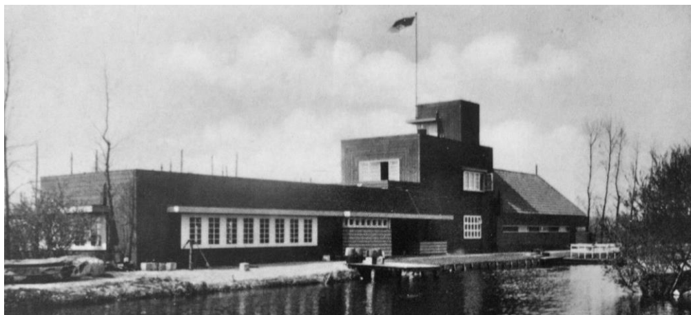
Het clubgebouw van de Watersportvereniging De Nieuwe Meer, 1926
