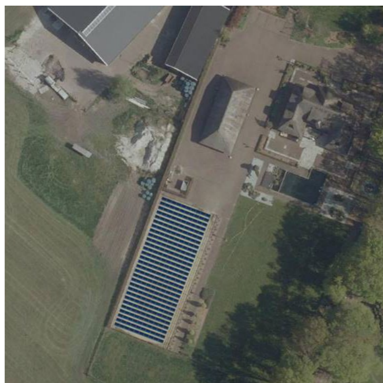
Achterop het erf, binnen het bouwblok, is plek voor een opstelling van zonnepanelen.
