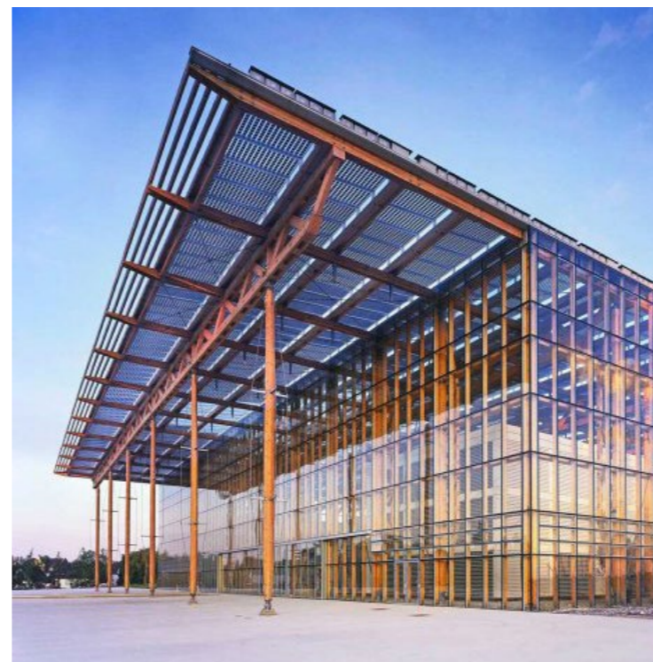
Zonnepanelen verwerkt in glas
