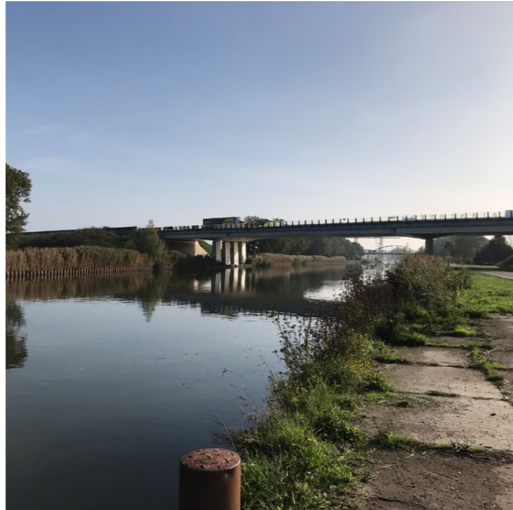
Het kanaal, de A35 en de twee bruggen zijn nadrukkelijk aanwezig en vormen de grenzen van het clustergebied.
