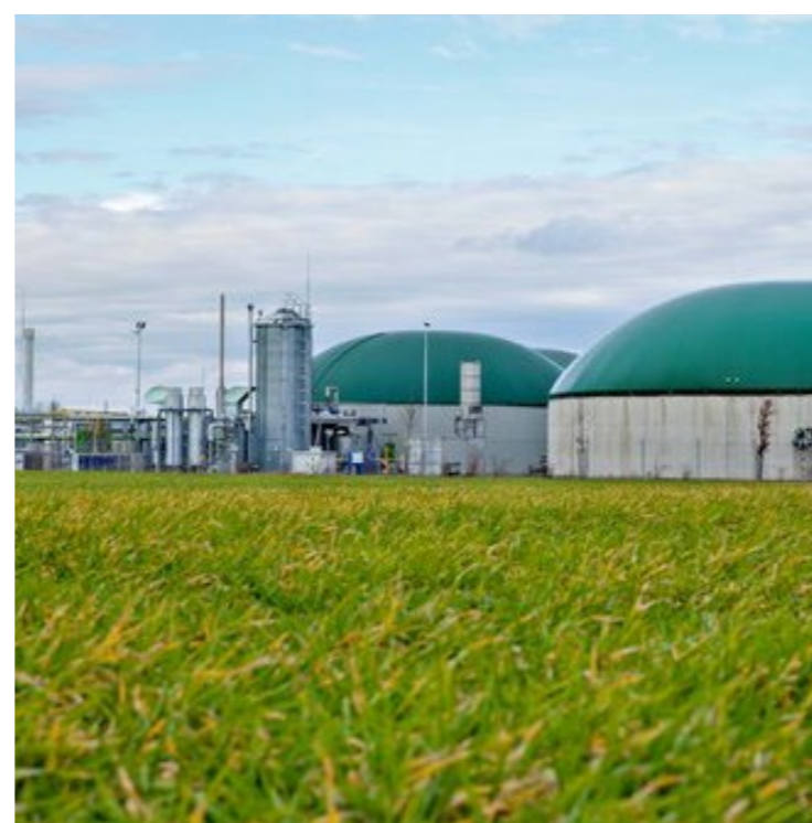
Grootschalige biogasinstallatie gekoppeld aan bedrijventerrein.
