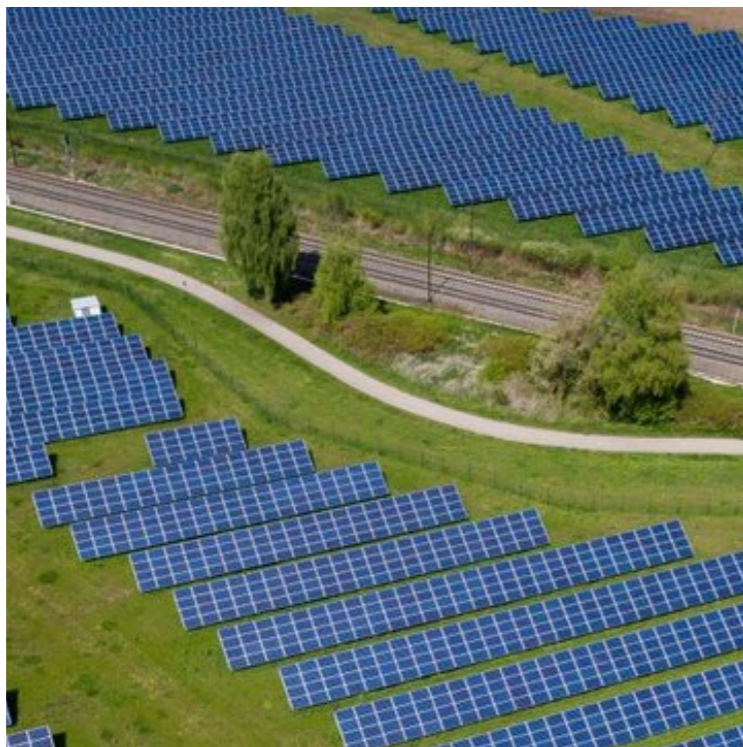
Brede randen en open ruimten door het zonnepark geven een vriendelijker beeld en meer kansen voor groen en water. Door aan te sluiten bij de maat en schaal van het landschap is het zonnepark beter ingepast in zijn omgeving.
