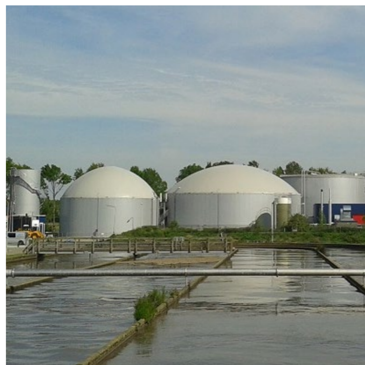
Biogasinstallatie gekoppeld aan RWZI.
