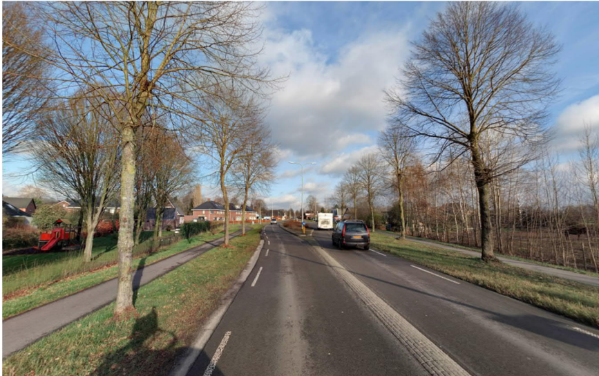
Afbeelding 14. Referentiebeeld gebiedsontsluitingsweg 50 km/u met vrijliggende fietspaden en brede middengeleider op het kruispunt
