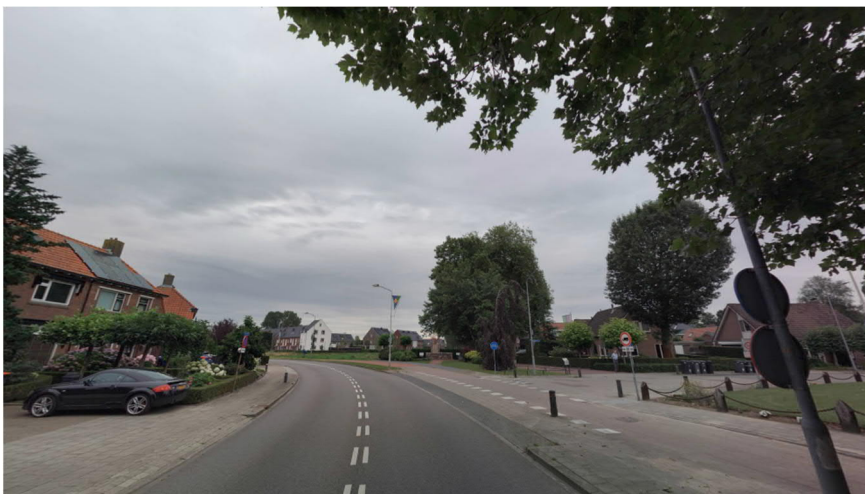
Afbeelding 13. Ontbrekende asmarkering op fietsoversteek aansluiting Kerkstraat
