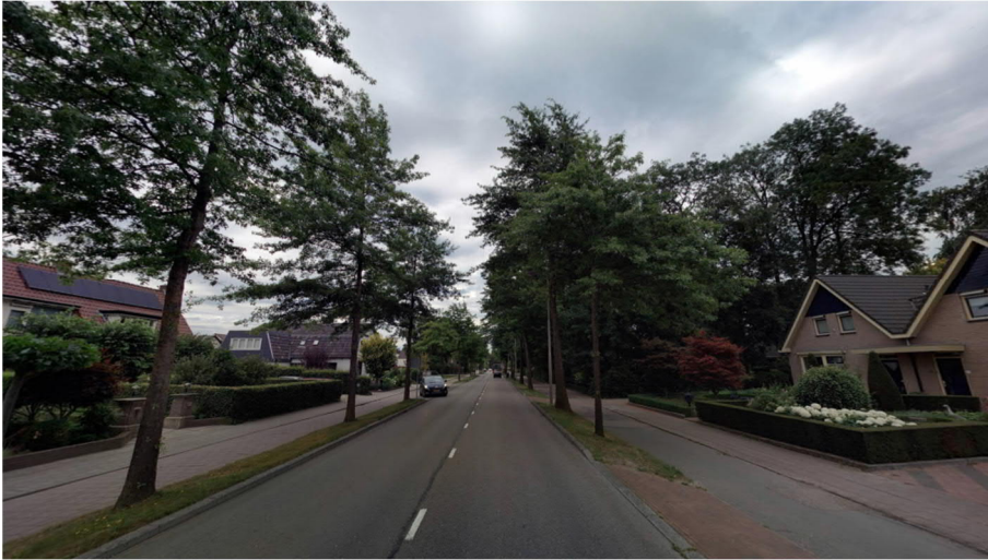
Afbeelding 7. Onderbroken asmarkering op Baron van Nagellstraat
