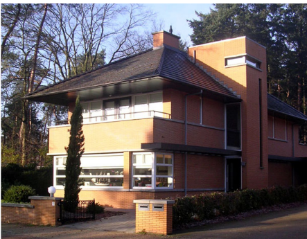
Kap op hoofd- en bijgebouw is verplicht, met de nok haaks op de Thorbeckelaan. De dakhelling van de kap bedraagt tussen de 30 en 45 graden.
