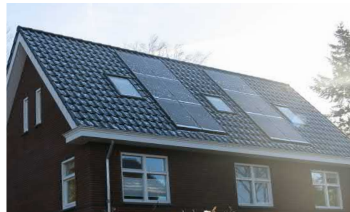
De situering van de zonnepanelen en overige duurzame energievoorzieningen zijn onderdeel van het architectonisch ontwerp
