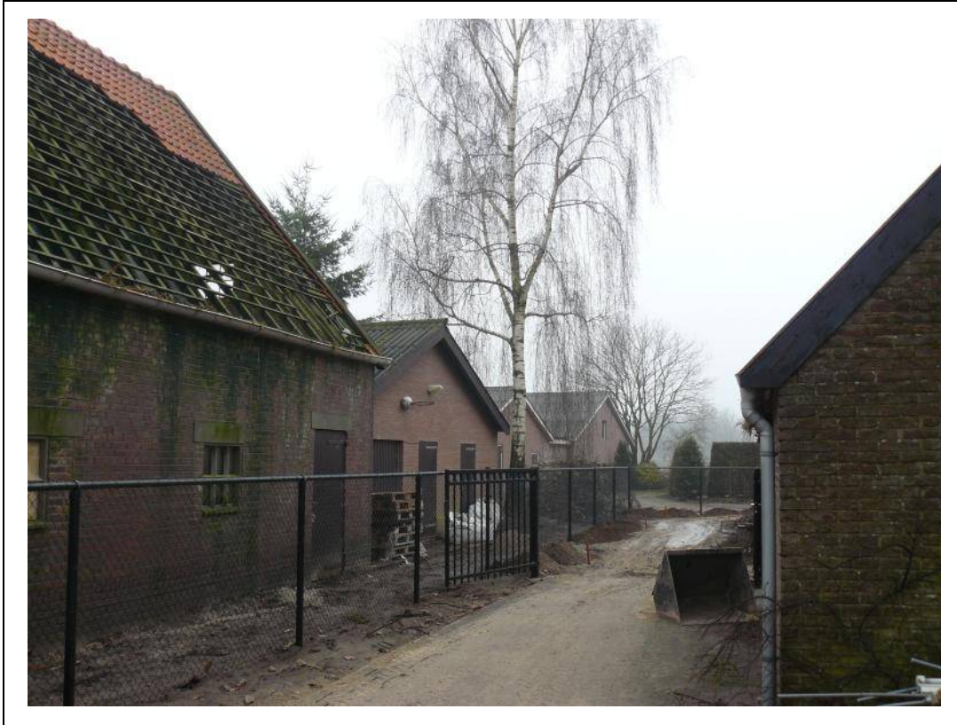
Foto 1. Oude koeienschuur met verwijderde dakpannen, varkensschuur en loodsen.
