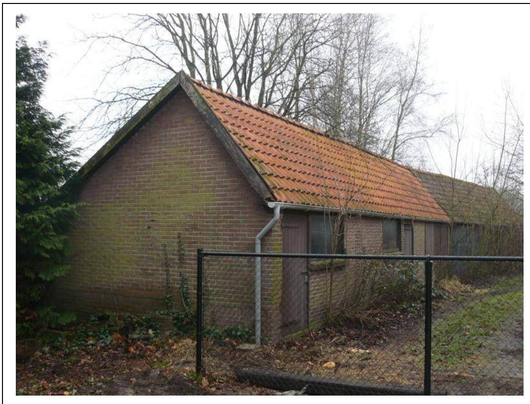
Foto 3. Schuren op zuidoostelijke terreindeel met kalverenschuur.
