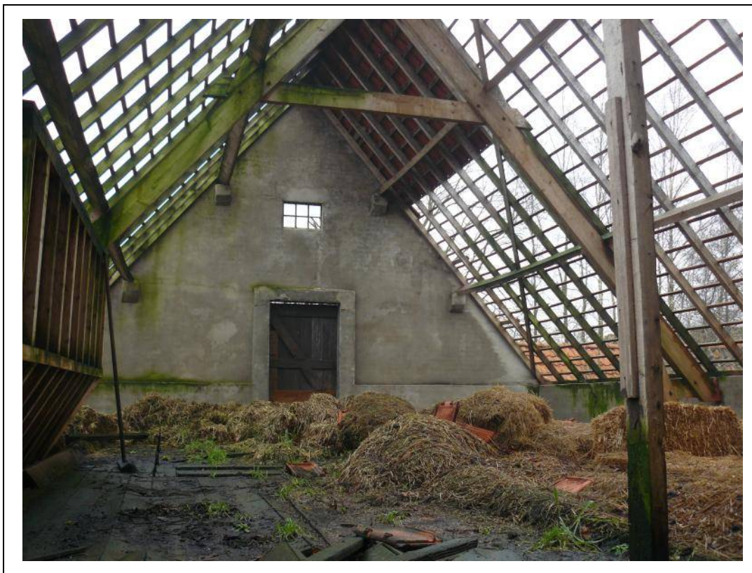
Foto 5. Zolderruimte voormalige koeienschuur.
