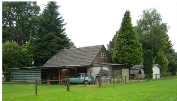
Foto 2: Zicht op achterzijde schuur vanuit grasland
