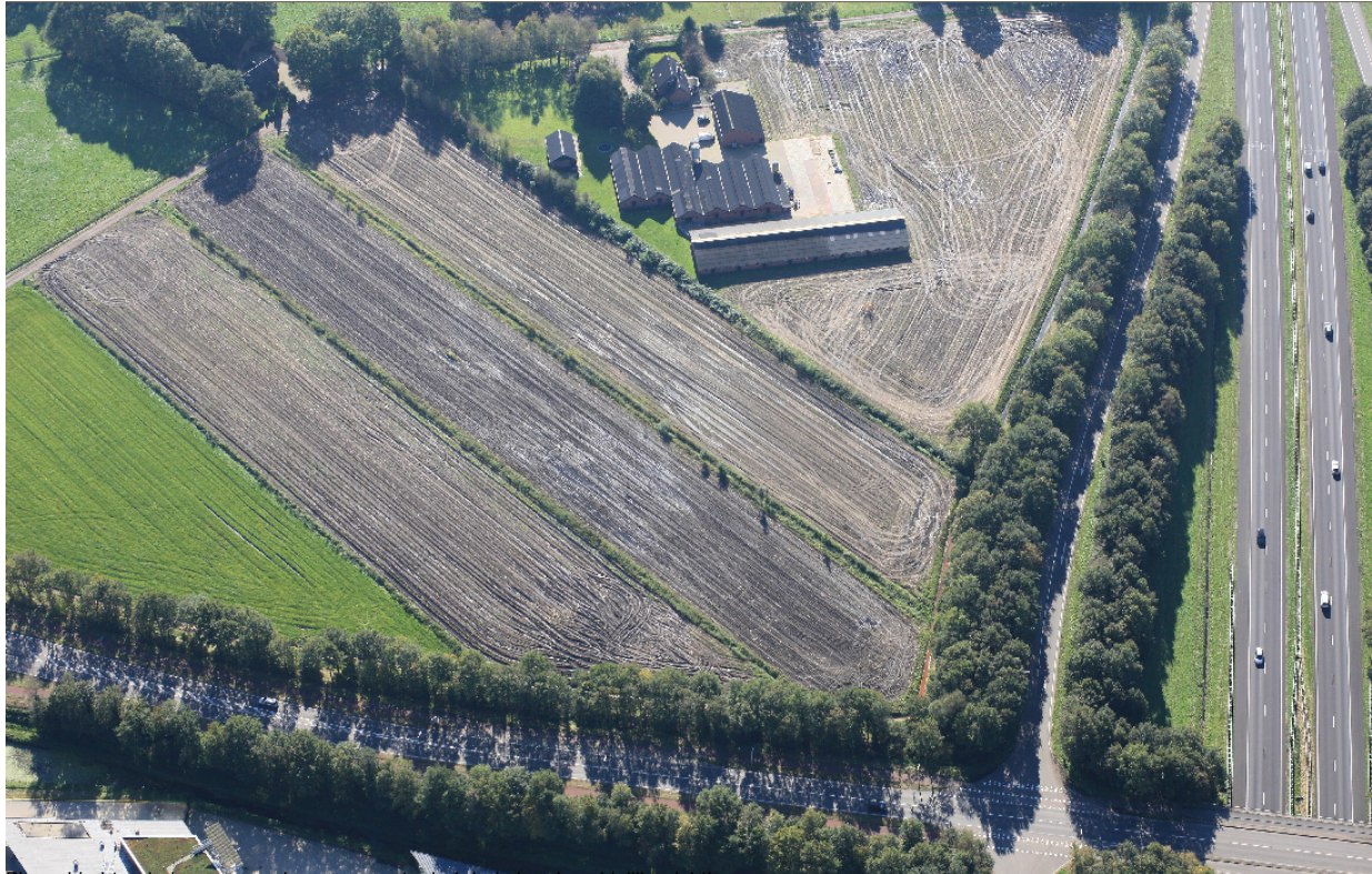
Plangebied ten behoeve van de evenementenhal, bekeken in zuidelijke richting
