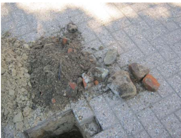
Foto 8: Materiaal uit inspectiegat G1
