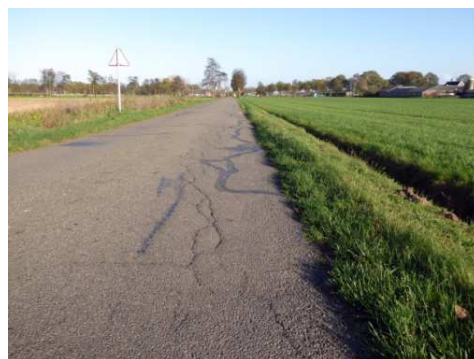
Foto 3.1 Muldersweg (scheurvorming)
