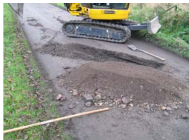
Foto 4: Asbestinspectiesleuf in halfverhardingsweg met minikraan voor het graven van de sleuven.
