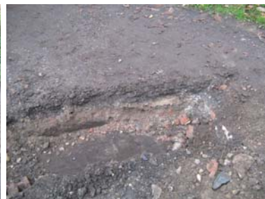
Foto 5: Asbestinspectiesleuf nader onderzoek asbest
