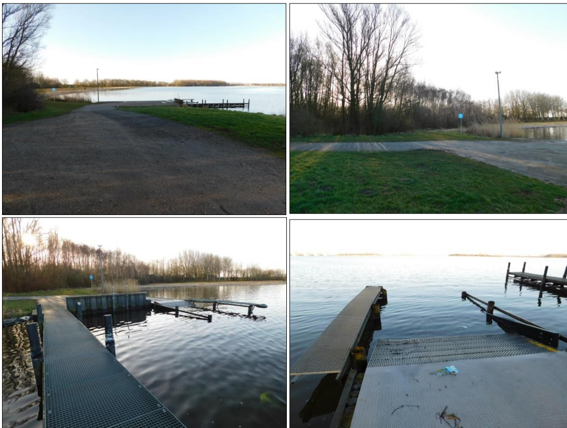
Foto's 1 t/m 4. Impressie van het projectgebied op 15 maart 2023. Linksboven het aanzicht op het projectgebied vanuit het noorden. Rechtsboven het aanzicht op het verharde deel van het projectgebied vanuit het noordwesten. Linksonder de steigers in het projectgebied. Rechtsonder de bestaande boothelling.
