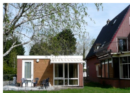
Figuur 2: mantelzorgwoning, foto Platform 31
