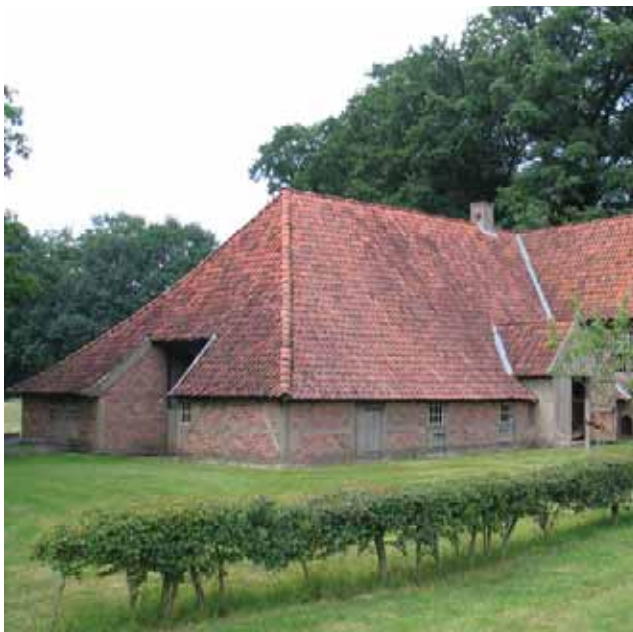
Voorbeeld van een onderschoer bij De Lebbebrugge.
