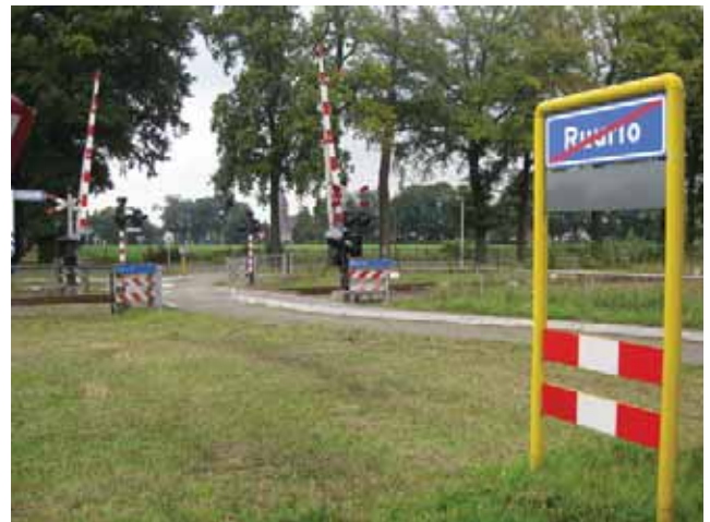
Spoorwegovergang bij Ruurlo.
