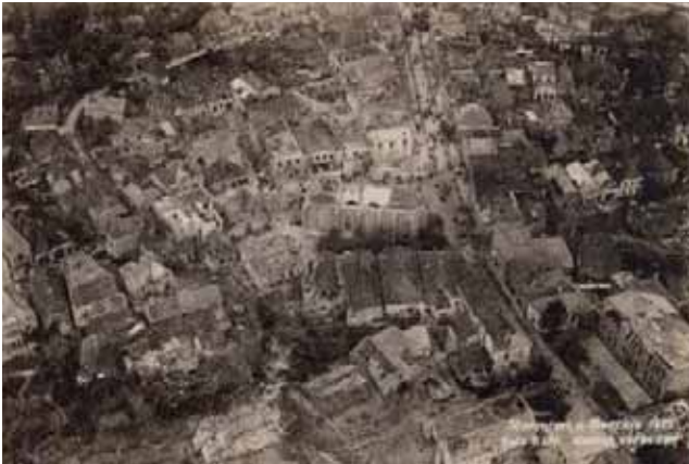
1925, de verwoestende werking van de stormramp in Borculo is goed zichtbaar.
