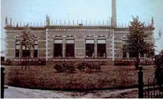
De jamfabriek aan de Stationsweg in Neede.
