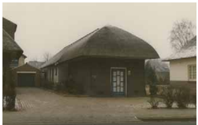
Trafohuisje van de EMB in Borculo.
