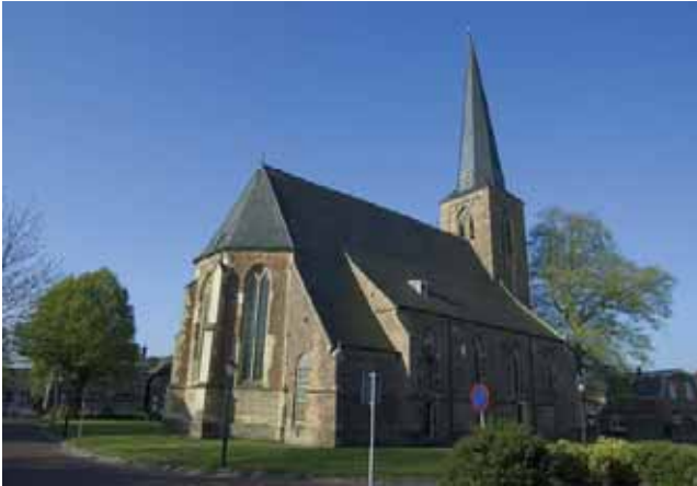
PKN kerk Eibergen. De laatgotische kerk was van oorsprong gewijd aan St. Mattheus. Het schip is gebouwd rond 1500. Herstelwerkzaamheden vonden plaats in 1820-1821, 1930 en 1950.
