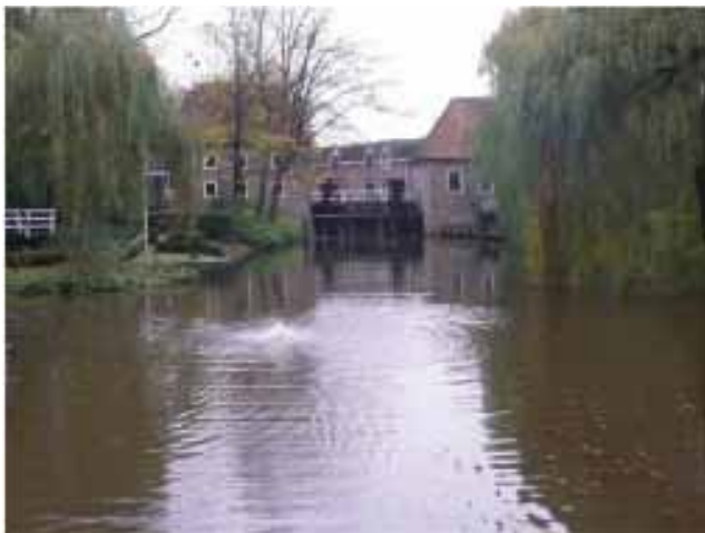
Watermolencomplex Borculo. De gebouwen dateren waarschijnlijk uit de 18 e eeuw. De molens vallen onder het type onderslagmolen. De molen op de zuidoever was een oliemolen en de molen op de noordoever een korenmolen. 41
