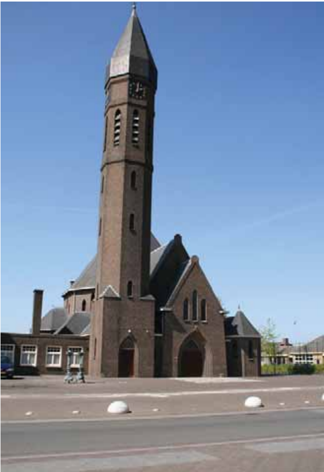
De Rooms Katholieke kerk van Rietmolen is gebouwd in 1933. De kerk is een ontwerp van architect C. Hardeman.
