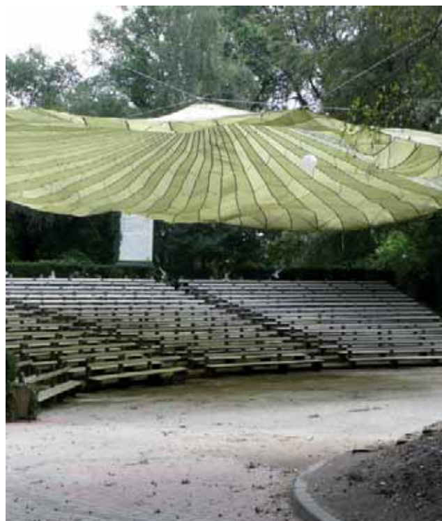
Houten tribunes van het openluchttheater.
