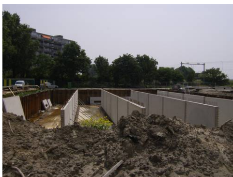
Figuur 4.1: Bergbezinkbassin (3700m 3 ) in aanbouw om overstortsituaties tegen te gaan
