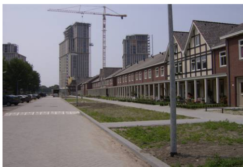
Figuur 4.6: In de Burgemeesterswijk is de wegfundering inmiddels voorzien van het duurzame hemelwatersysteem Aquaflo
