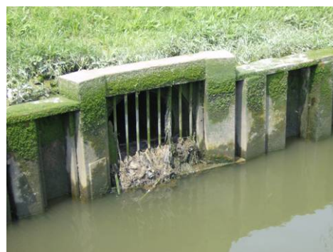
Figuur 4.2: Overstort Maassluis-West op haven
