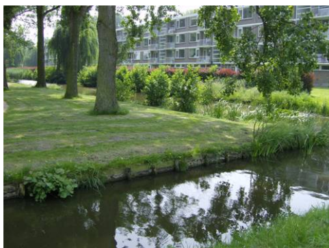
Figuur 7.2: Beschoeiing
