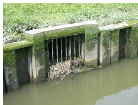
Figuur 4.2: Overstort Maassluis-West op haven
