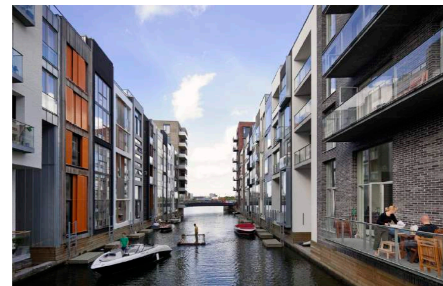
Sluseholmen, Kopenhagen Verbijzondering door ander materiaal en kleur Metselwerkverbanden, balkons en betonbanden ter versterking van de plastiek
