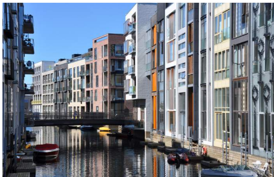
Sluseholmen, Kopenhagen De openbare ruimte loopt niet weg maar wordt omsloten door gebouwen
