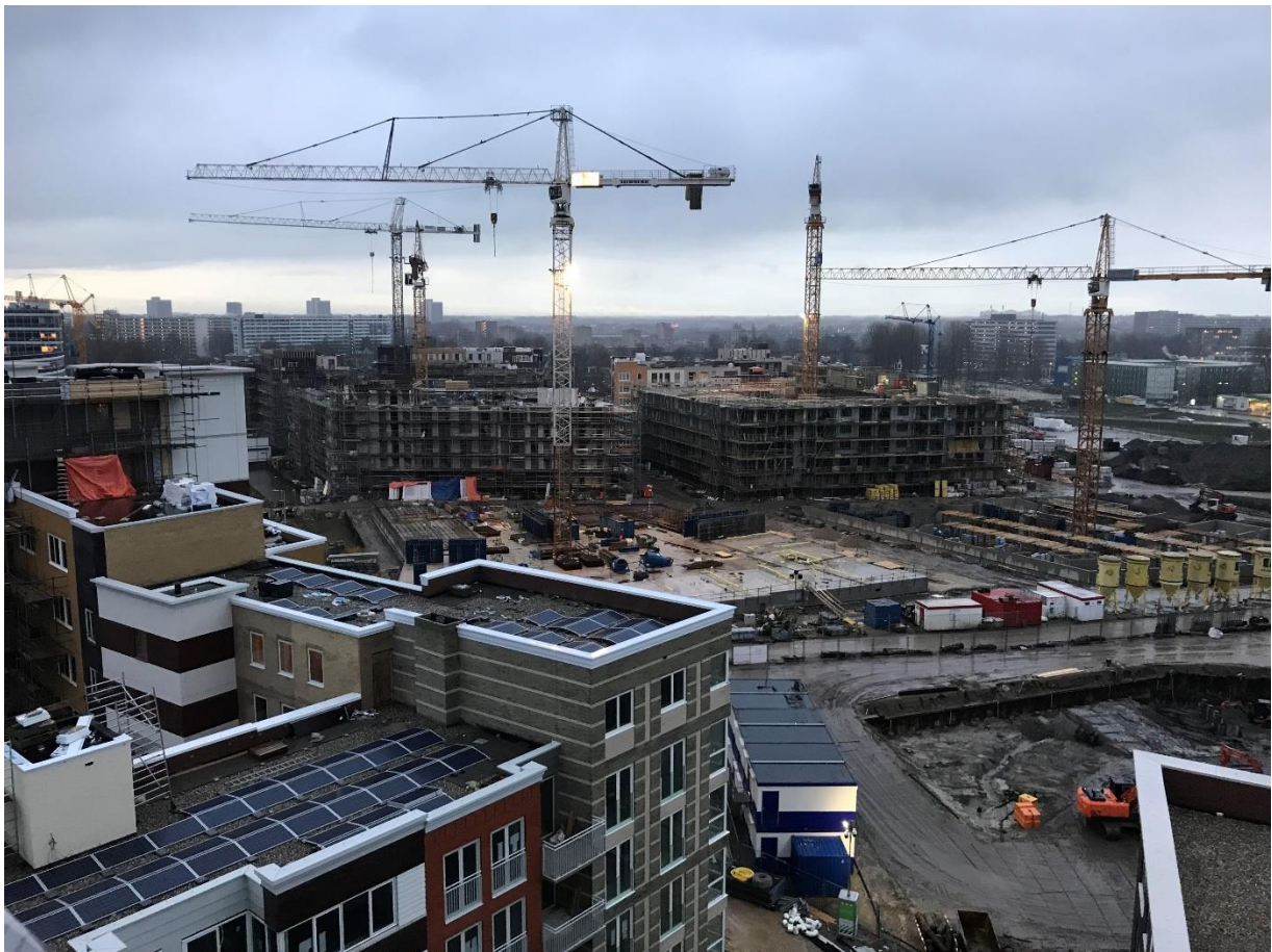
Afbeelding 7: Bouwwerkzaamheden Holland Park in volle gang
