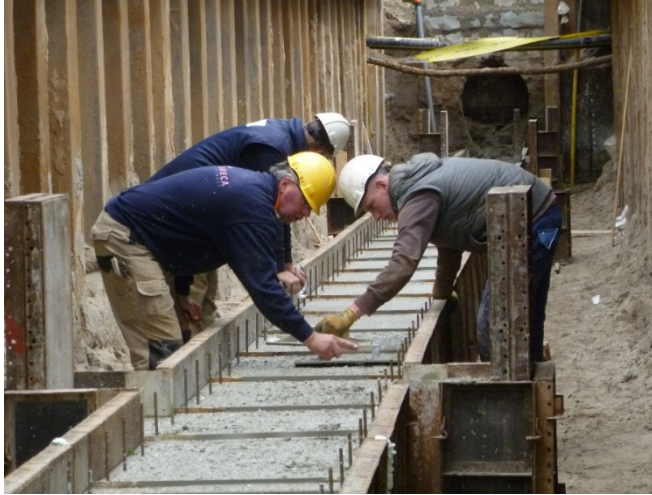
Betonnen funderingsbalk Schoolstraat
