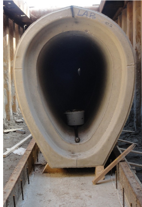
Betonnen rioolbuis op betonnen funderingsbalk
