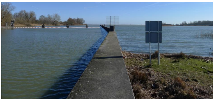
Figuur 7. Zicht op de Baai van Ballast (rechts) en de afschermende damwand. Locatie van de voorziene steiger is links, net buiten beeld.
