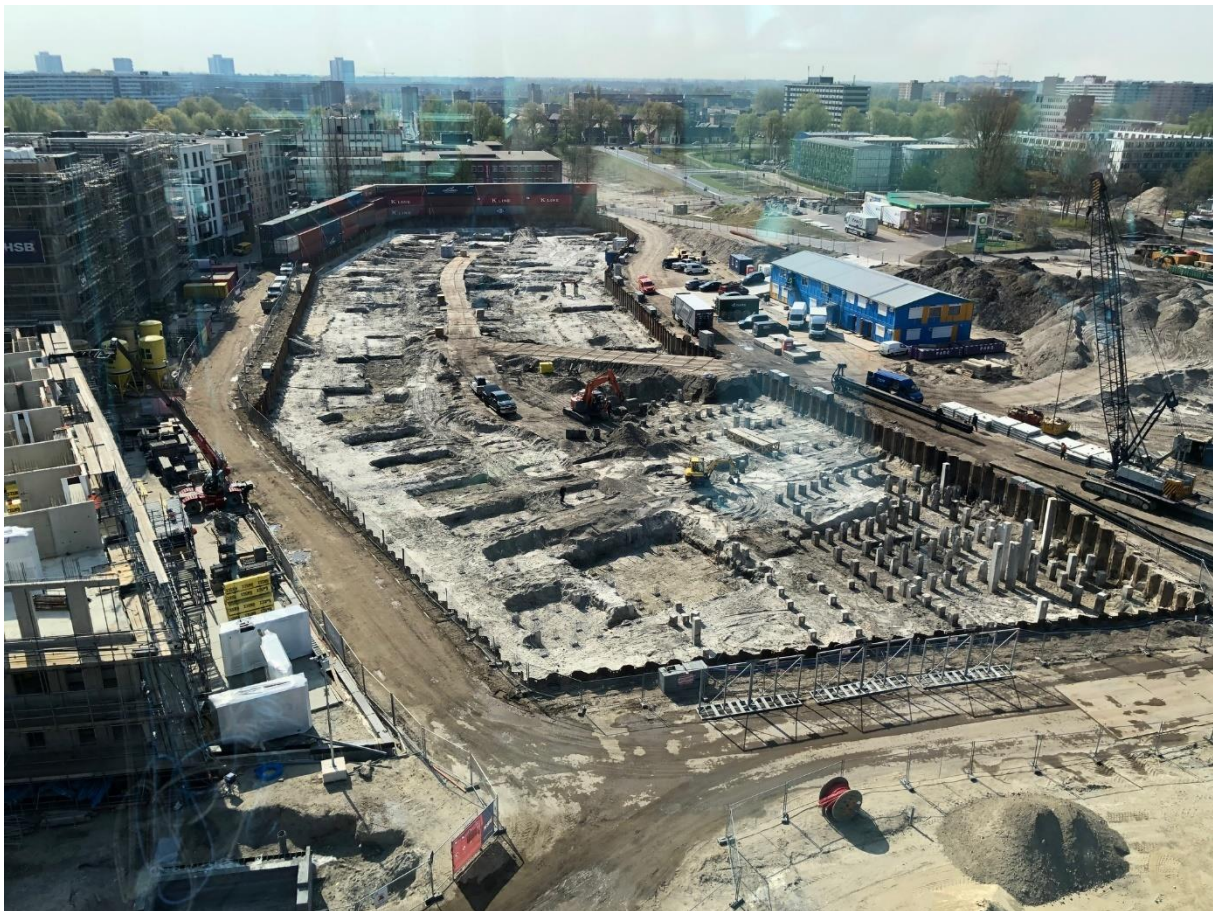
Afbeelding 2: Bouwwerkzaamheden parkblokken 22 en 23 Holland Park in volle gang.
