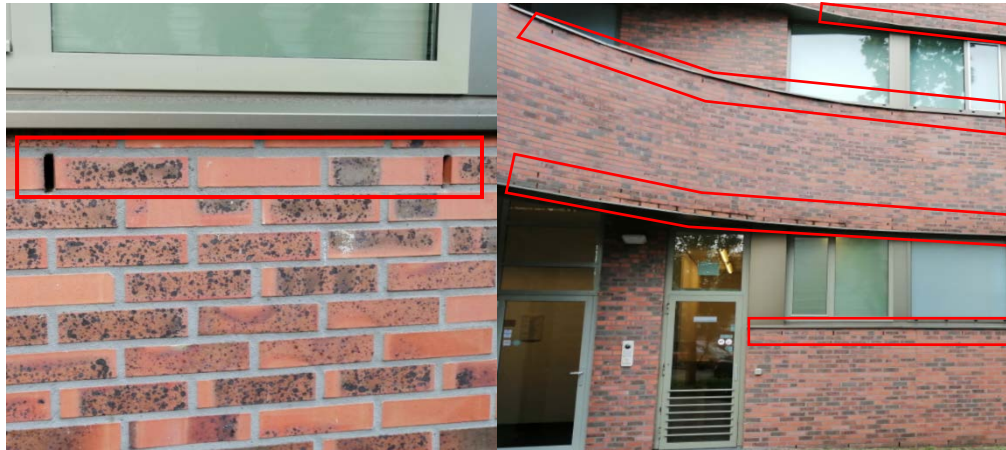
Figuur 3.1 Open stootvoegen in het pand ten zuiden van en grenzend aan het plangebied
