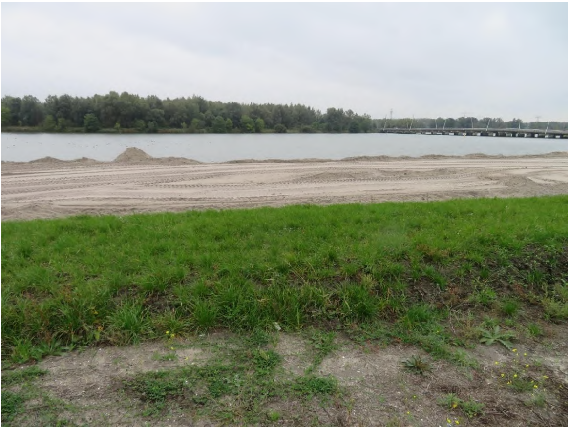
Reeds nieuw aangelegd land in IJburg. Het tracé loopt van de Diemervijfhoek (moerasbos op achtergrond), door het Markermeer en sluit aan op dit nieuwe land.
