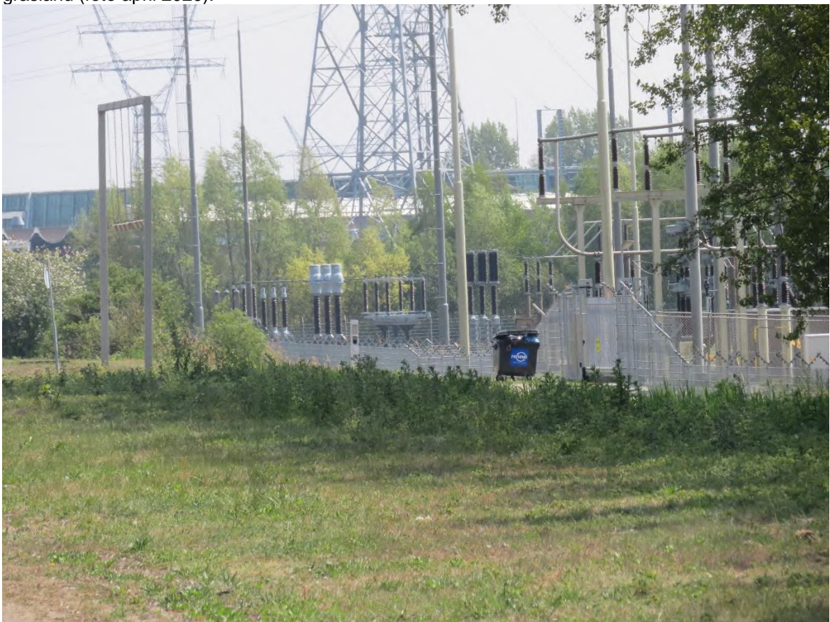
Tussen de bomen op de achtergrond en de elektriciteitscentrale is een braakliggend stuk gemaaid grasland waar de werkzaamheden plaatsvinden (foto april 2020).
