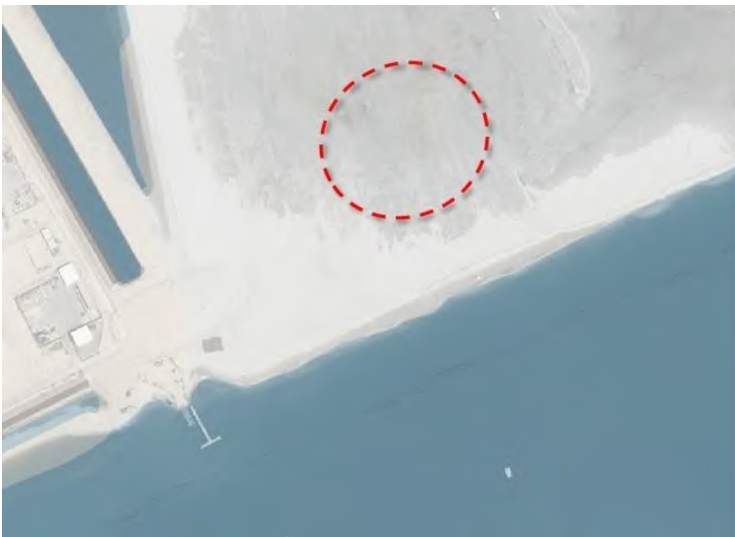
afbeelding 4: luchtfoto van het in aanleg zijnde nieuwe Strandeiland bij IJburg, met rode cirkel is de beoogde locatie van het nieuwe onderstation ongeveer aangeduid.
