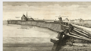
Afbeelding van de dijk zoals deze vroeger is aangelegd met behulp van houten palen. Vanaf 1730 zijn de palen vervangen door stenen vanwege paalworm.
