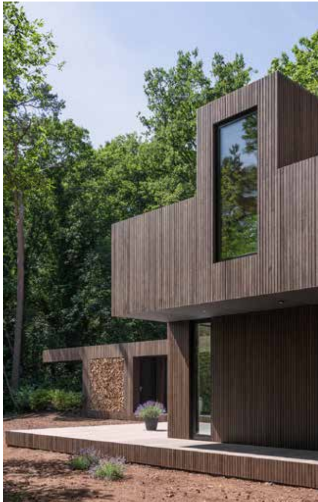
Referentiebeeld woningbouw met een bamboe gevel
