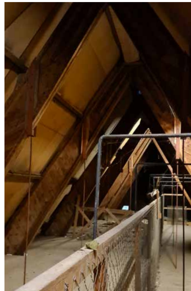
Spanten in de De Grote Rietschuur
