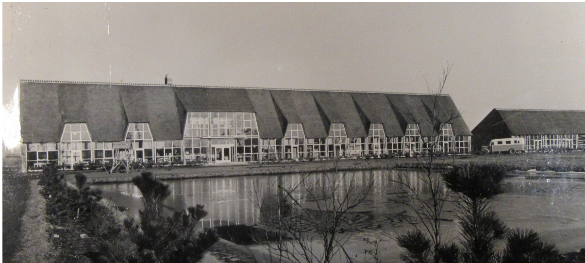
Links het hoofdgebouw en rechts de inmiddels gesloopte kleine rietschuur, vanuit zuidelijke richting gezien. Ongedateerde foto, bron: Het Nieuwe Instituut, fotograaf waarschijnlijk J. Versnel.
