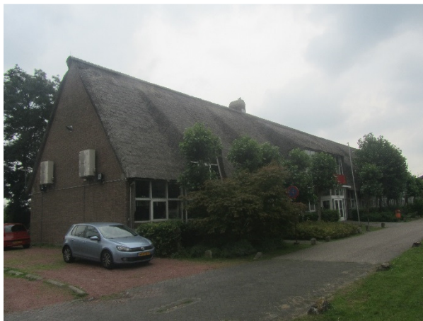
Overzicht westgevel en zuidgevel
