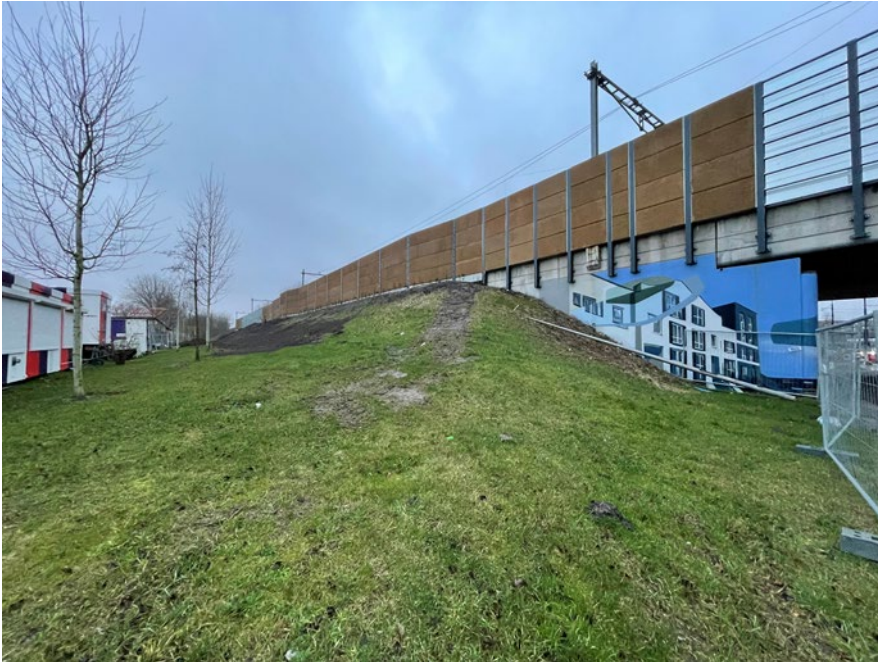
Afbeelding 4: De geluidschermen nabij Plantage de Sniep in aanbouw
